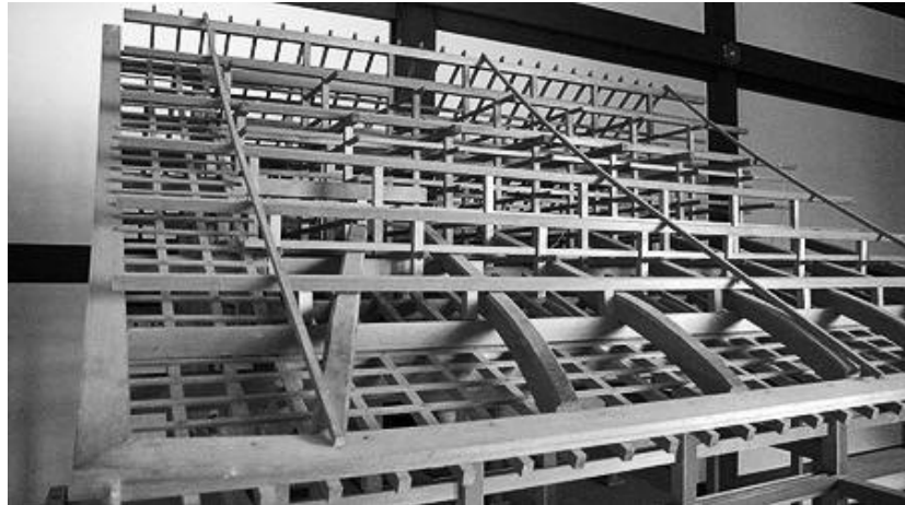
Charpente du Temple de Gokayama, Japon (maquette). Photo : www.doremy.fr - Tokyoremite
