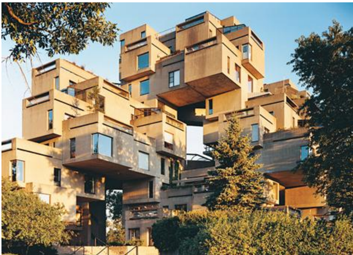
Les Appartements d'Habitat '67 construit par Moshe Safdie à l'occasion de l'exposition de Montréal de 1967.
