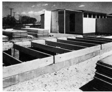
Le General Panel System. En haut : l'articulation en acier et le détail d'une jonction et d'un angle. En bas : Les panneaux prêts à l'assemblage, les fondations, la construction d'un rdc. In op. cit., p.85
