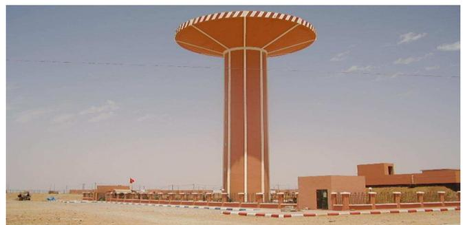
Réservoir surélevé de 500m<sup>3</sup> et semi-enterré de 3 250m<sup>3</sup> à El Wahda à Laâyoune
