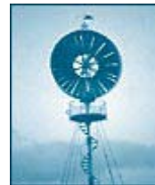
L'éolienne Bollée à Quarante (Hérault)
