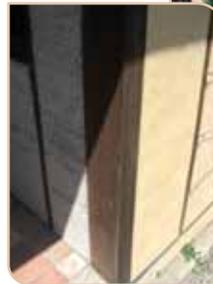
Aligné bois du béton de chanvre sur la partie droite (OSB gauche), isolant sur la côté exposé aux intempéries (OSB droit) (photo : ARPE)
