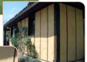
Détail des bois exposés (démontables) avec remplissage en laine de chanvre banché (photo : ARPE)
