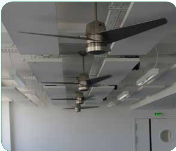
Immeuble Mediacom à Saint-Denis © TRIBU
