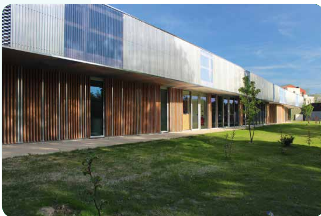
Façade Nord-Ouest © Colomes Nomdedeu
