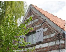
Figure 47 : réinterprétation de la technique rouge-barres Source : photographies personnelles, mars 2017
