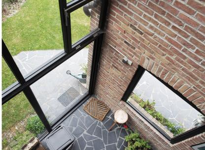
Figure 59 : les serres côté jardin se déploient sur deux niveaux et favorisent le gain direct Source : photographies personnelles, mars 2017
